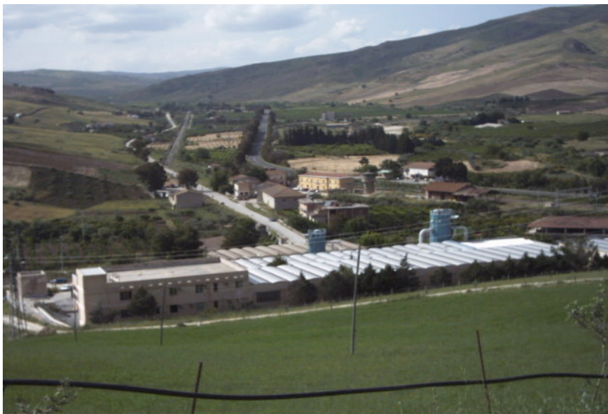
Foto n. 1 – Inquadramento del sito produttivo
